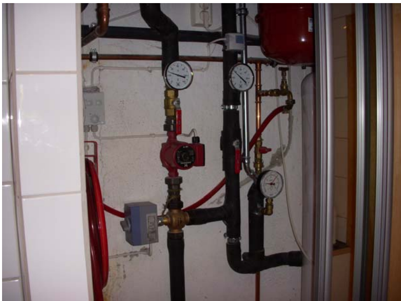
Bilde 1. Varmesentral plassert i skap i bad/sokkeetasje. Foto: Mads Mysen
