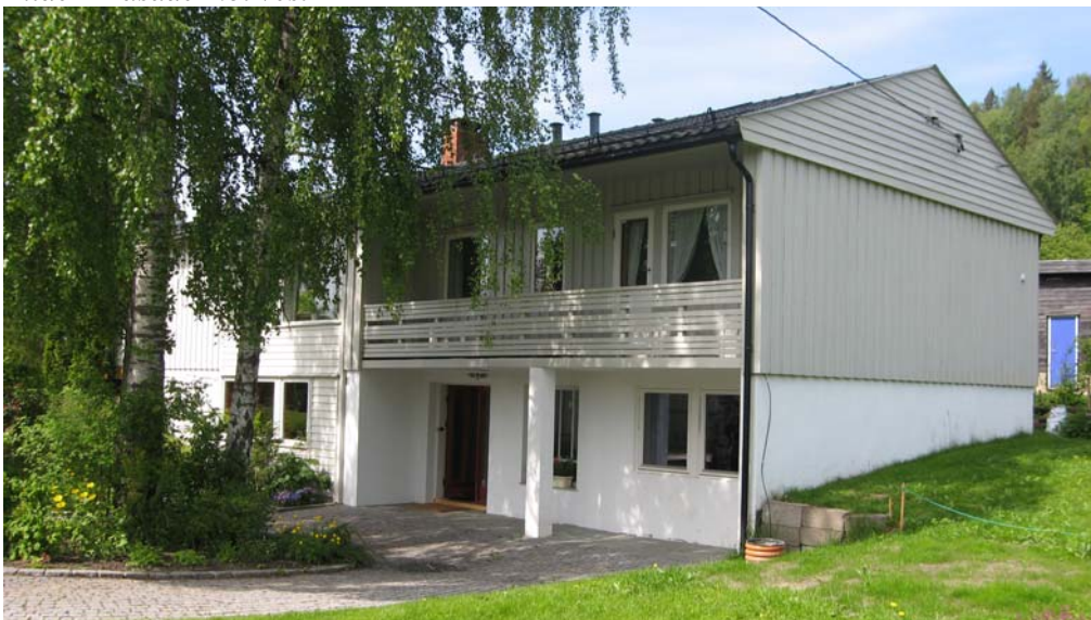
Bilde 2 Fasade mot sør og øst
