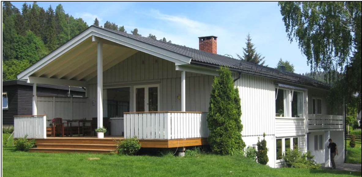
Bilde 2 Fasade mot sør og øst
